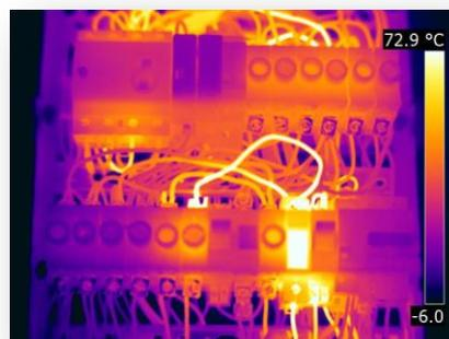
La détection des échauffements anormaux dans les armoires électriques (connexions défectueuses, composants fatigués) permet de réduire le risque d'incendie ou l'arrêt de la production de froid.
